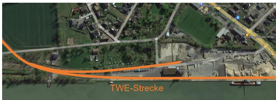
Abbildung 7: Luftbild des Hafengebiets Dörenthe (Google Earth, 21.03.2024)
